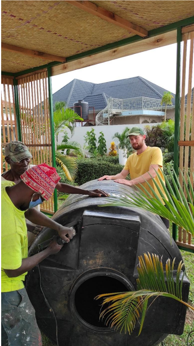
Découpage des cuves en vue de l'assemblage du digesteur familial.
