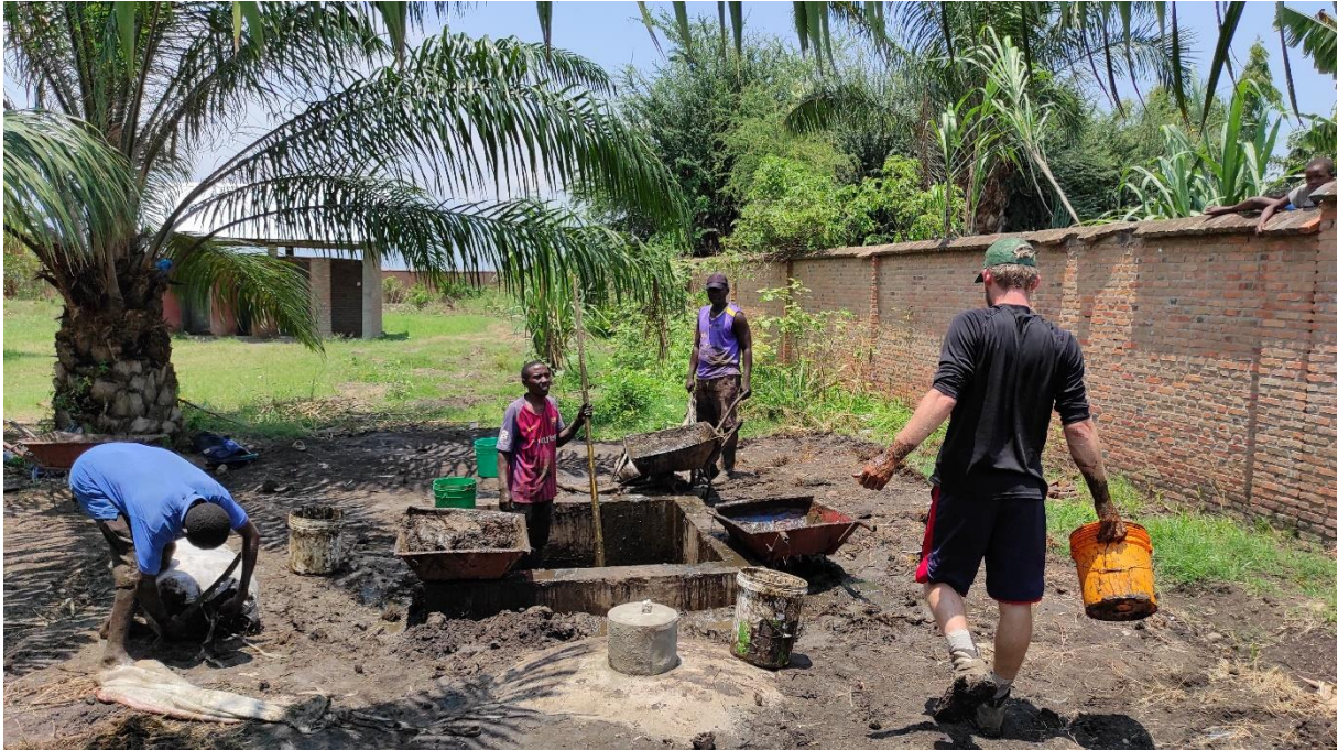
La construction du digesteur enterré à l'école Kanura est terminée, place au remplissage des 3 tonnes de bouses de vache mélangées à l'eau.
