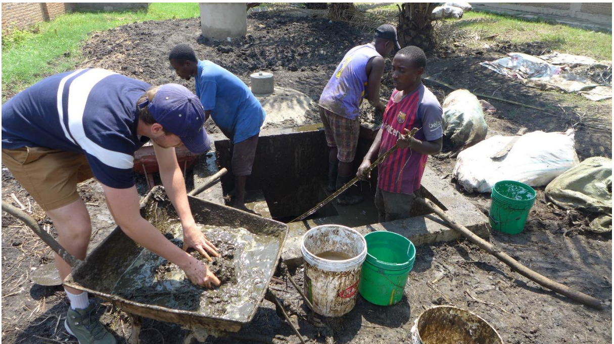
Deux jours durant, les étudiants avec l'aide de trois ouvriers ont dû se salir les mains jusqu'à ce que le digesteur soit rempli.
