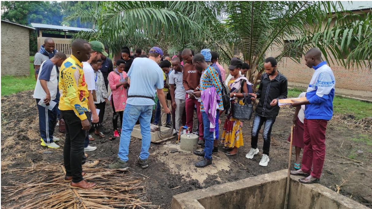
Après la théorie, on visite le chantier, les étudiants sont très intéressés, ils participent à une analyse de la composition du gaz.
